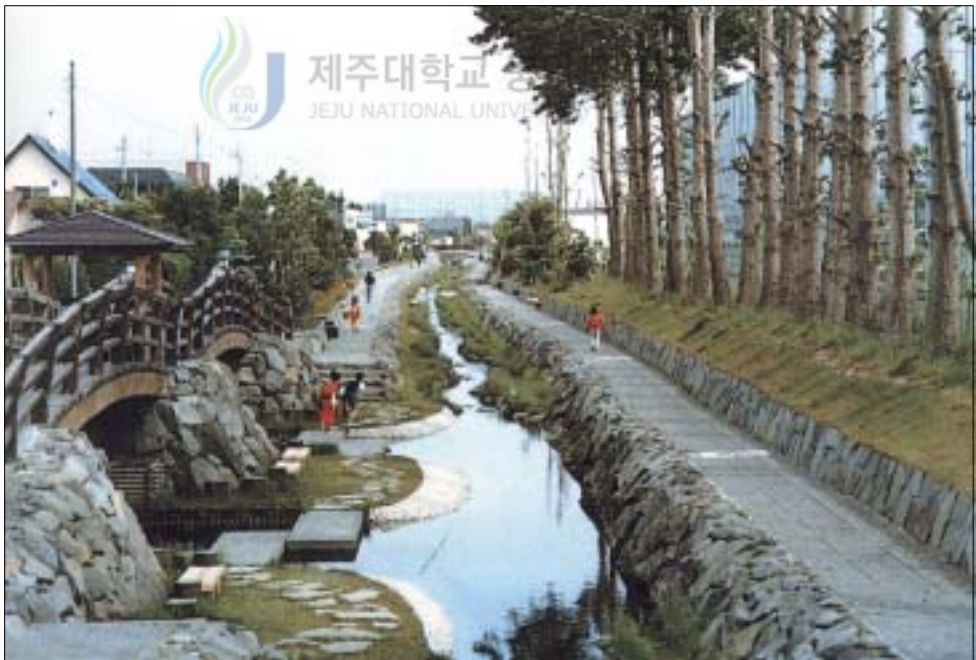
(b) 친수기능형 하천의 복원후 전경
