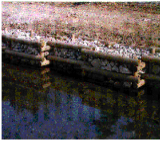
(a) 나무틀 공법 공사직후
