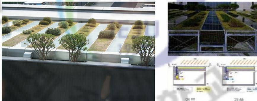
그림 3-16. 옥상부분에 설치된 그린 카페트와 태양열 집열덕트 위치와 구조도
