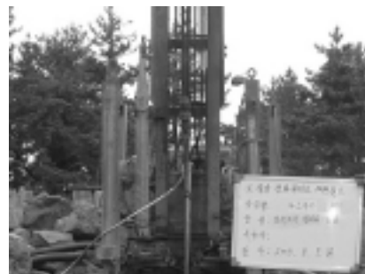
(d) Laying electrode
