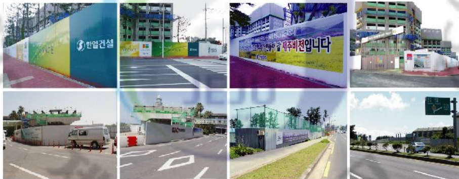
그림 65 제주시 지역 공사 가림막
