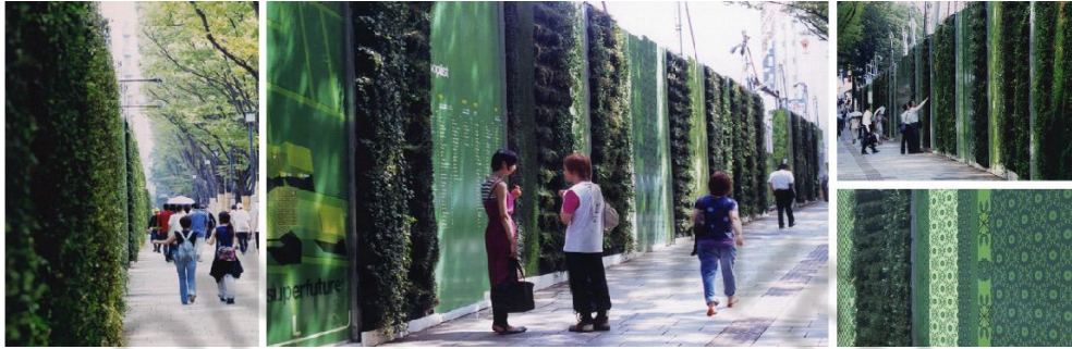
그림 22 일본 도쿄 하라주쿠 오모테산도 아오야마 아파트 재건축 공사 가림막 (출처: http://blog.naver.com/gaykay/140106727076 )
