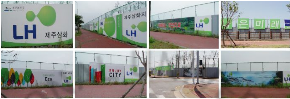
그림 64 제주시 삼화지구 아파트 공사 가림막
