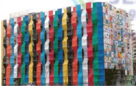
그림 74 서울시 문화재단 리모델링 공사 가림막 (출처: 권영길, 권영길의 공공디자인 산책)
