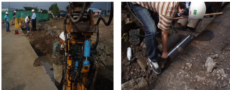
그림 4.3 무진동 암 터파기 공법의 모니터링 및 측정 전경
