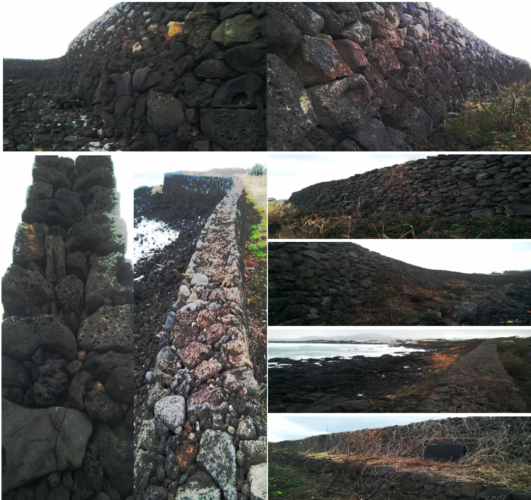
<그림11-1> 별도 환해장성 복원 후 모습 길이 620m, 높이 2.5m, 폭 1.2m(상단 좌우, 왼쪽 세로 사진, 2007년 복원)
