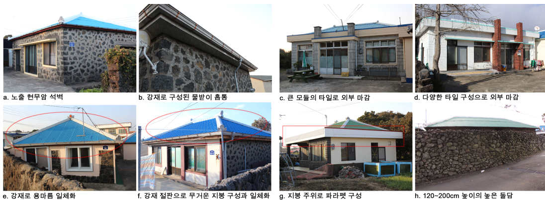
그림 11. 바람과 습기에 대응하는 건축특징(a~d: 습기 대응, e~h: 바람 대응)
