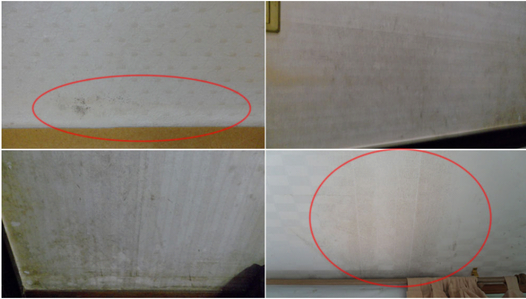
그림 18. 하절기 조사 민가의 벽체 하부와 모서리, 접합부에서 나타난 실내 결로
