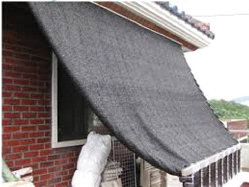
그림 15. 외부 차양막 설치 사례
