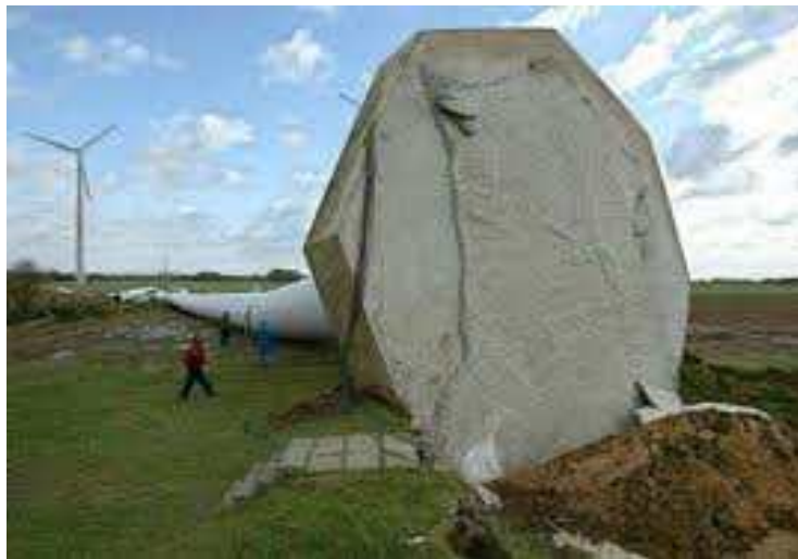
Fig. 2 기초 결함으로 인한 풍력터빈 전도[7]
