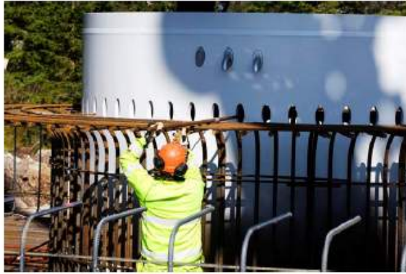
Fig. 10 앵커링 형식 상부철근 조립과정[14]
