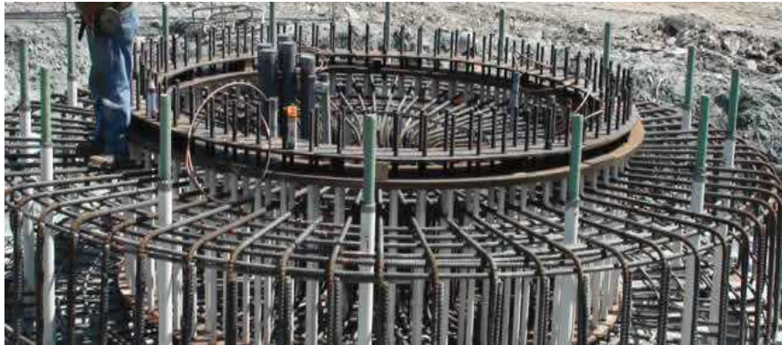
Fig. 12 기초 콘크리트 타설 전 앵커볼트[16]
