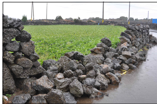
[그림 IV-20] 강풍에 의해 무너진 밭담의 모습(하도리 A지구)
