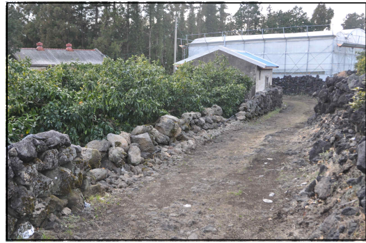
[그림 V-19] 차량 통행으로 인해 한쪽 측면(왼쪽)이 훼손된 밭담
