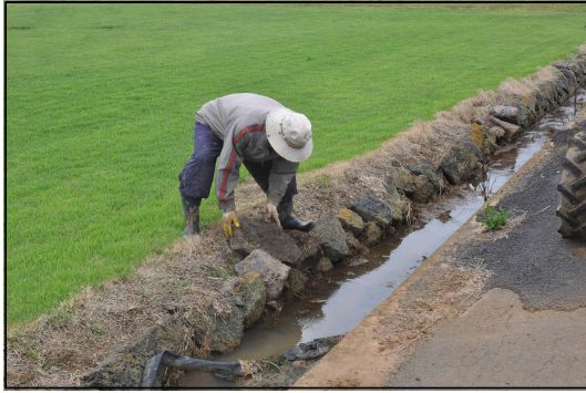
[그림 III-9] 배수로 주변 방축을 쌓는 모습
