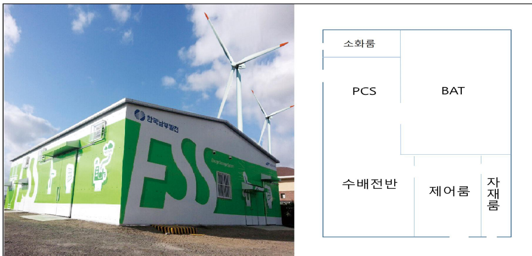
그림 10 에너지저장시스템 건물사진 및 구성
