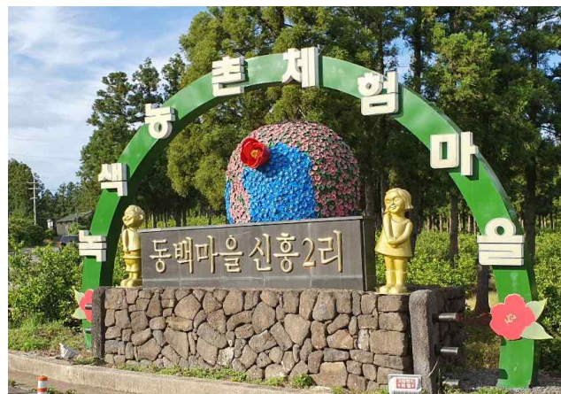
<그림 13> 신흥리 동백마을 상징조형물 보수 후 (2018)
