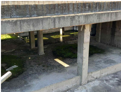
공사장 지하 1층
