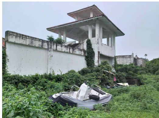
공사현장 주변 보트 방치
