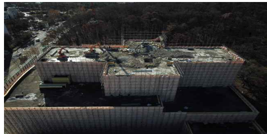
[그림 4] 우정병원 철거 후 사진
