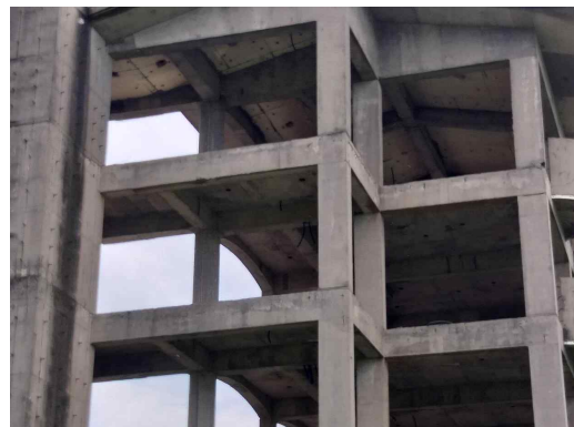
공사현장 건물 내부
