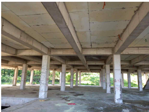
공사현장 건축물(1층 내부)
