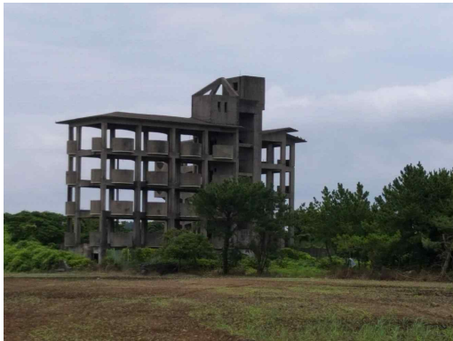
공사현장 공사가림막 미설치
