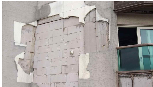
[그림 16] 고성리(I호텔) 바닥 배수 불량 [그림 17] 고성리(I호텔) 외벽 단열재 탈락
