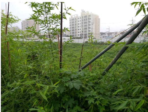
공사현장 내부 무성한 잡풀
