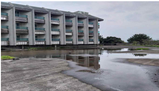
[그림 16] 고성리(I호텔) 바닥 배수 불량 [그림 17] 고성리(I호텔) 외벽 단열재 탈락
