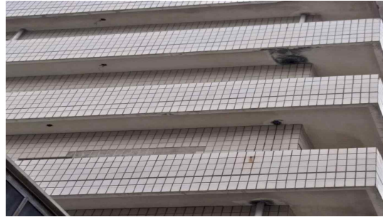
[그림 14] 삼도1동(서사라) 도로변 유리창 파손 [그림 15] 삼도1동(서사라) 외벽 타일 탈락
