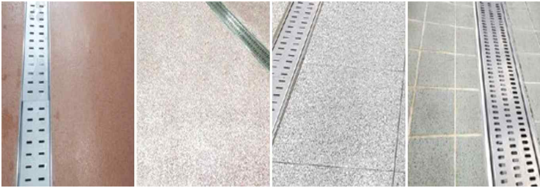
그림 2. 조리장 내 바닥과 트렌치 연결 부위
