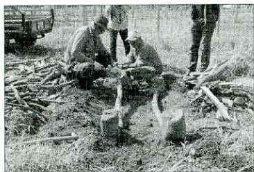
〈그림 8〉 곶숯 가마 하단부에 통나무 설치하기
