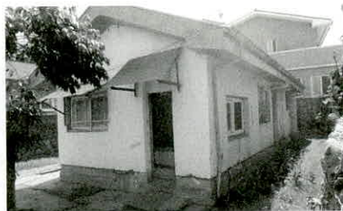
사진28. 현존 공영주택 후면
